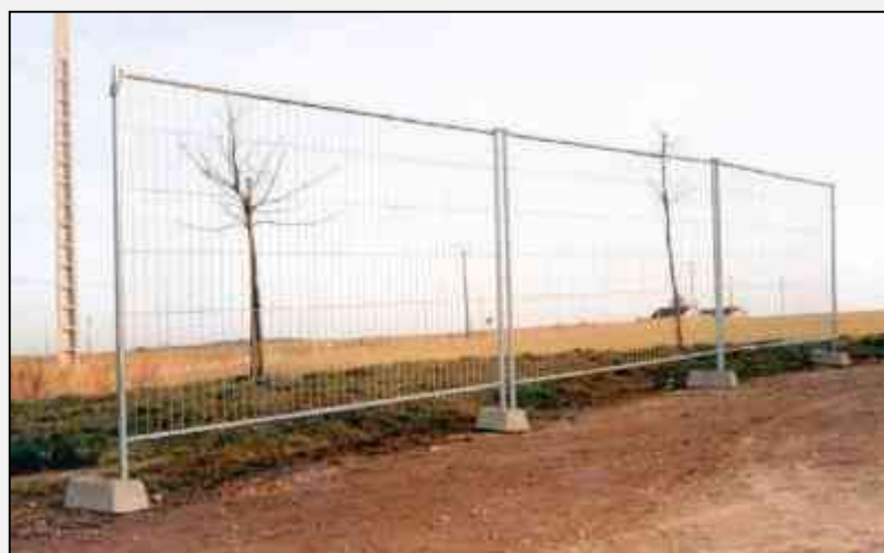
Figure 1 - Figure 39 : Exemple de palissade de protection de chantier (source www.signals.fr )
